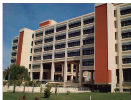
1. Centro Cívico. Proyecto: Arquitectos A. Antonini, J. Llauró, G. Schon, J. Urgell y E. Zemborain. Anteproyecto: 1971. Construcción: 1976 – 1979 (primera etapa) / 2005 – 2009 (segunda etapa).
